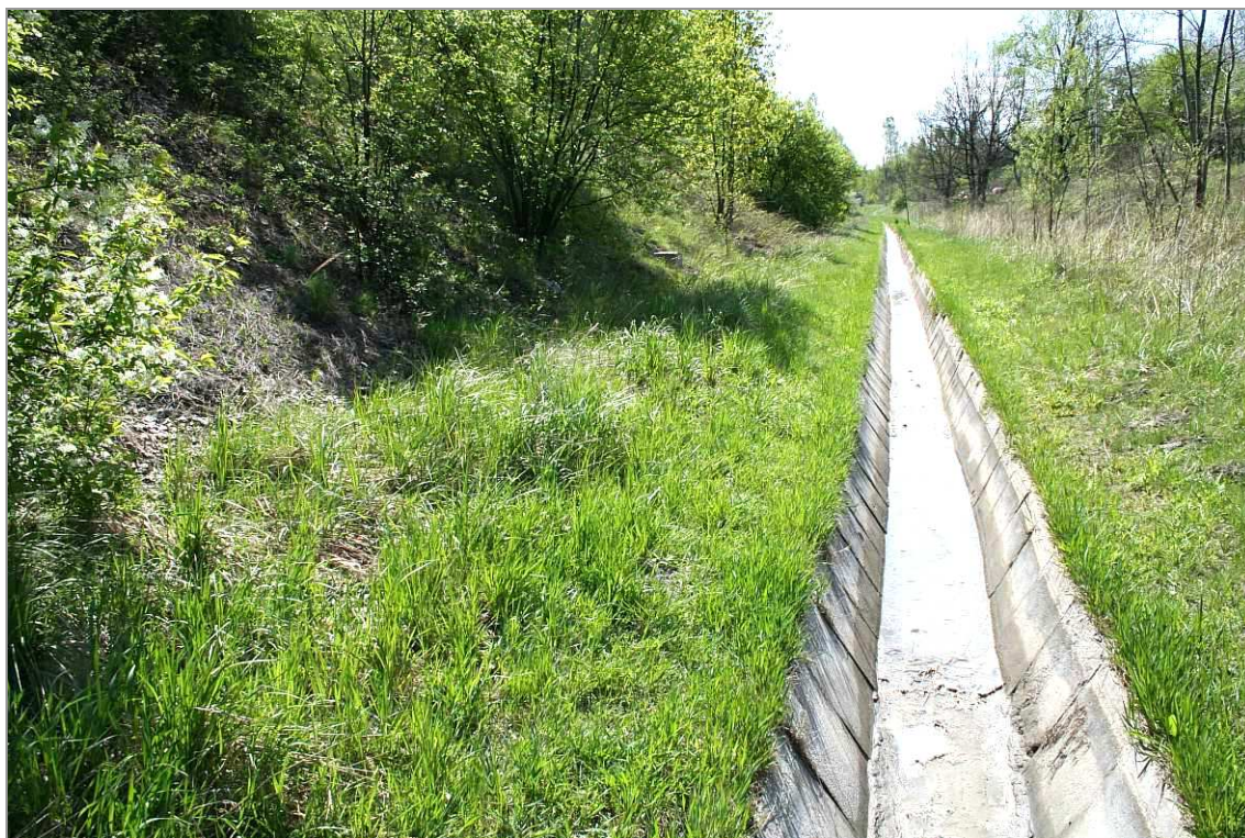
FOT. 8. RÓW OPASKOWY Z ZASOLONYMI WODAMI U PODNÓŻA OSADNIKA II (maj 2007 r., widok w kierunku wschodnim wzdłuż ul. Podmokłej).
