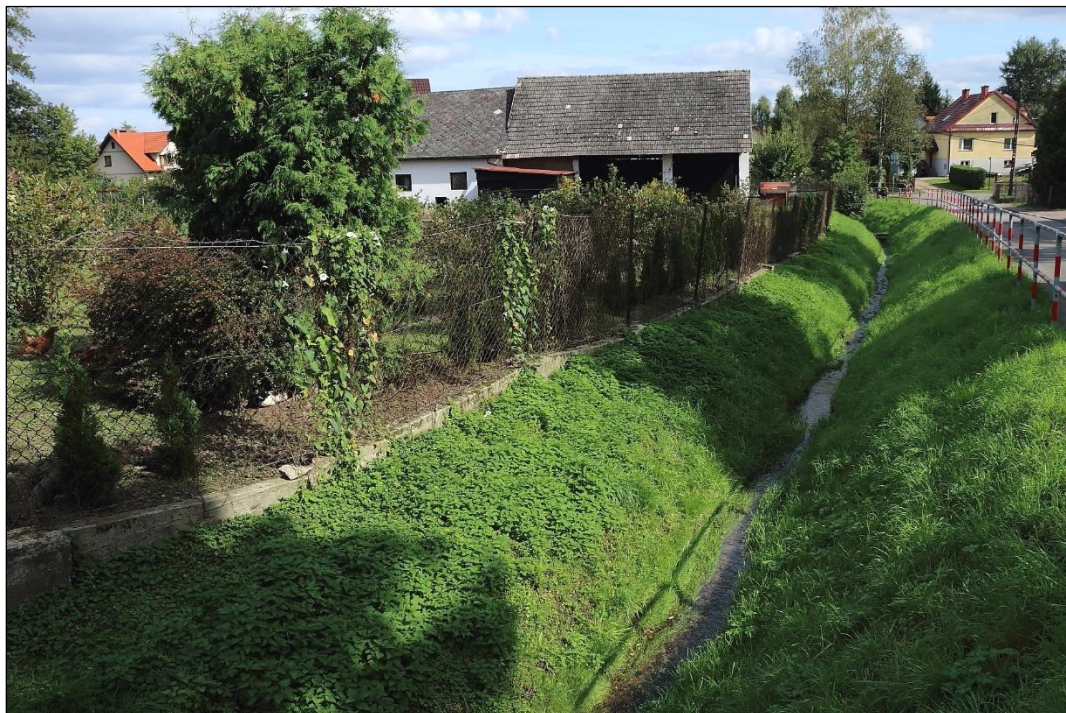
Fot. 5. Odpływ ze Źródła Olszanickiego na wysokości ul. Jadwigi Majówny. Dolny bieg, widok w kierunku północnym, 14.09.2019 r.
