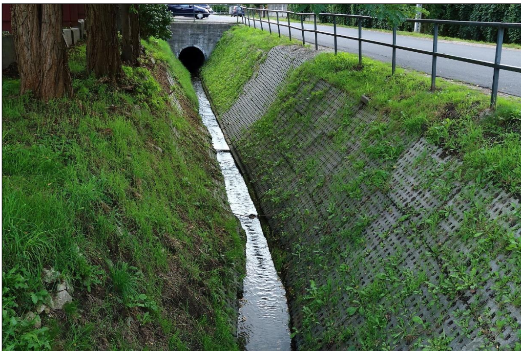
Fot. 4. Odpływ ze Źródła Olszanickiego na wysokości ul. Korzeniaka. Środkowy bieg, widok w kierunku południowym, 14.09.2019 r.
