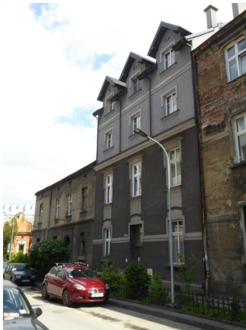
Fot. 7. Przykład nadbudowy niedopasowanej do otoczenia, wyróżniającej się w sposób negatywny (fot. Katarzyna Kupiec).
