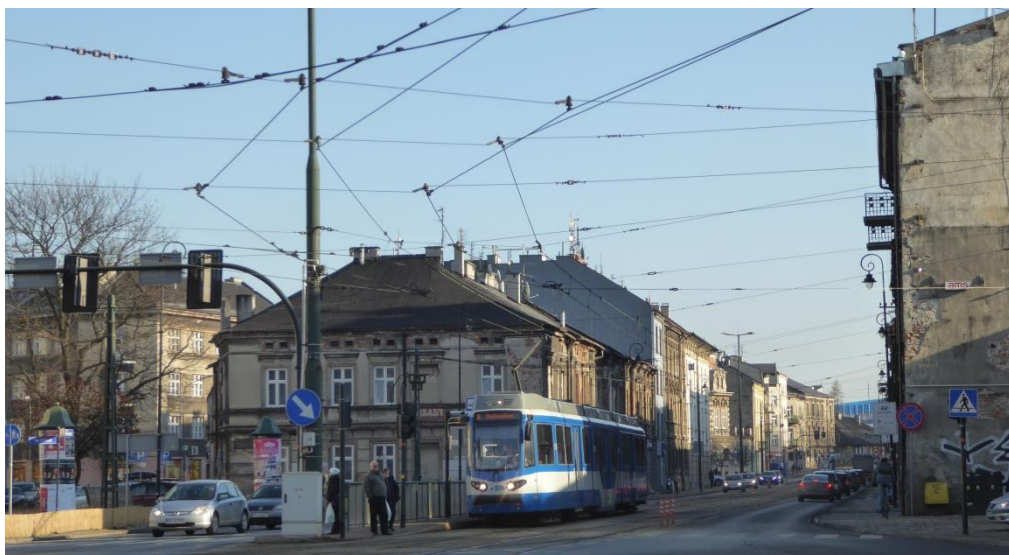
Fot. 1. Ciąg zabytkowych kamienic wzdłuż ul. Limanowskiego.
