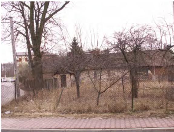
Fot.15 ul. Waleriana Łukasińskiego stara zabudowa
