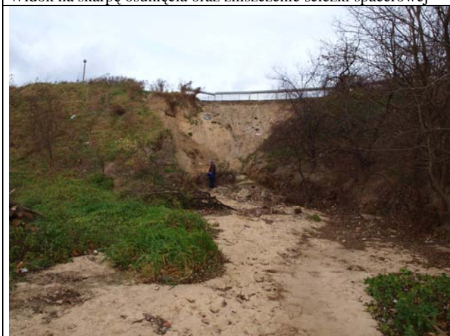
Widok na stożek powstały w wyniku spłynięcia materiału
