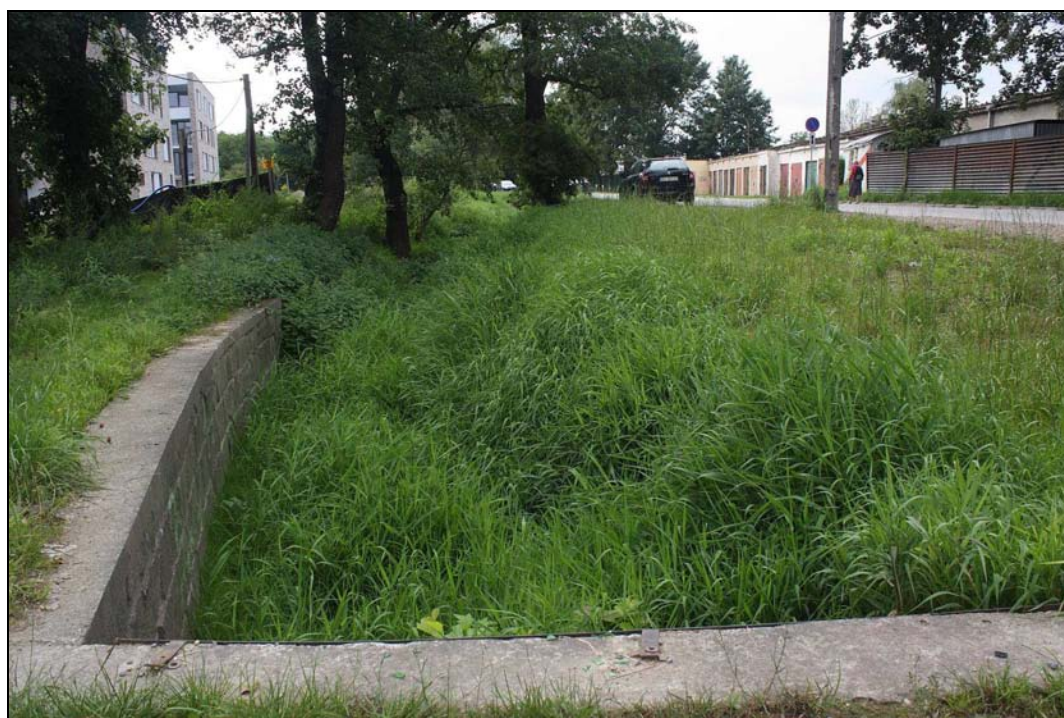
RYC. 14. MŁYNÓWKA KRÓLEWSKA NA WYSOKOŚCI UL. FILTROWEJ Widok w kierunku zachodnim, wzdłuż ul. Filtrowej, 24.08.2016 r.
