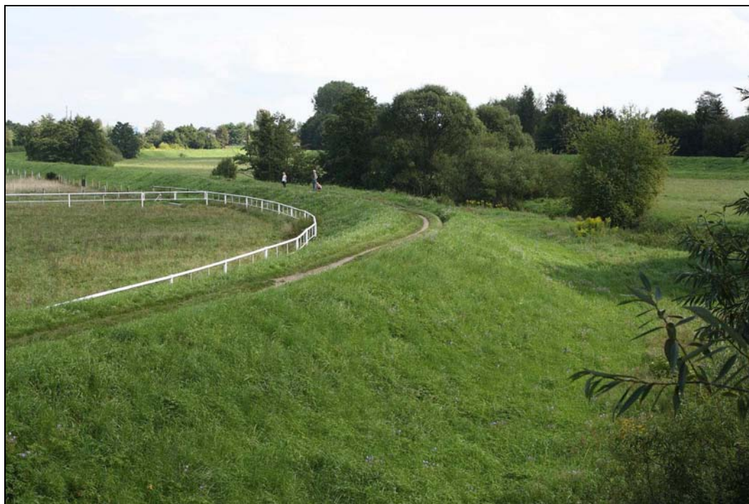
RYC. 11. WAŁ LEWOBRZEŻNY I MIĘDZYWAŁE RUDAWY NA WYSOKOŚCI UL. NAD ZALEWEM Widok w kierunku południowo-wschodnim, 24.08.2016 r.
