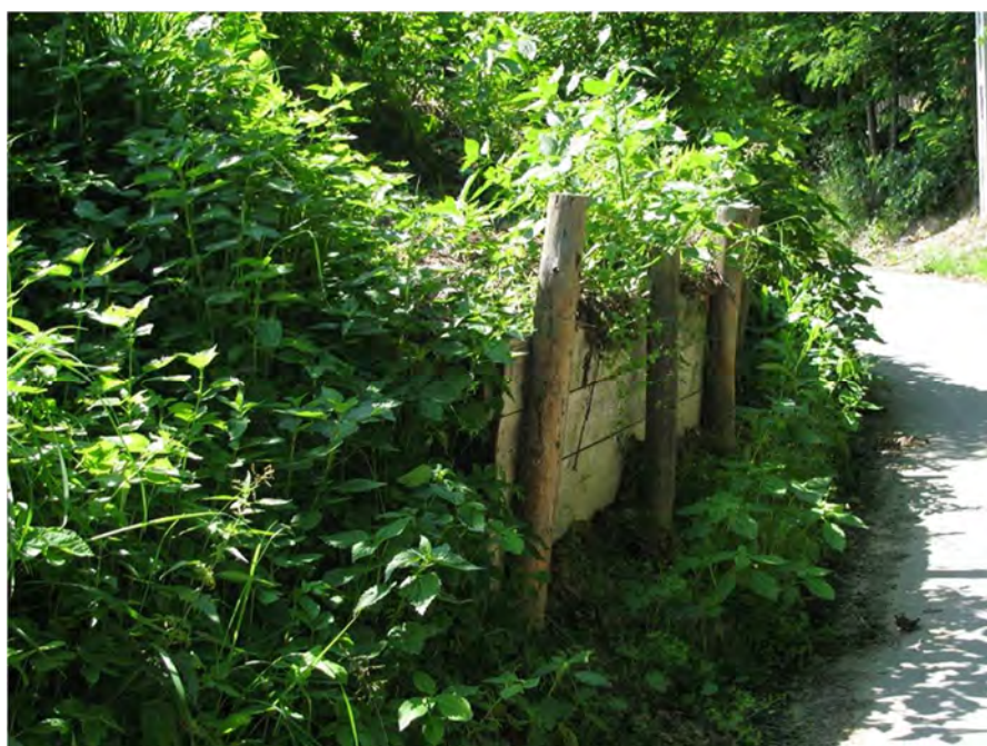
Fot. 2.18. Zabezpieczenie przed osuwaniem się ziemi (zabudowania powyżej) oraz przed przedostaniem się materiału na drogę, Rajsko (fot. J. Kowalczyk).
