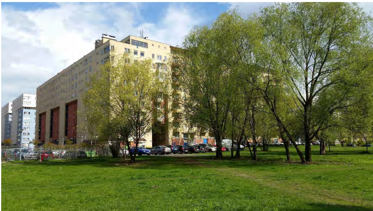
Fot. 8. Nowa zabudowa osiedla Oświecenia (przykładowy budynek wielorodzinny). Źródło: fotografia własna (kwiecień 2017).
