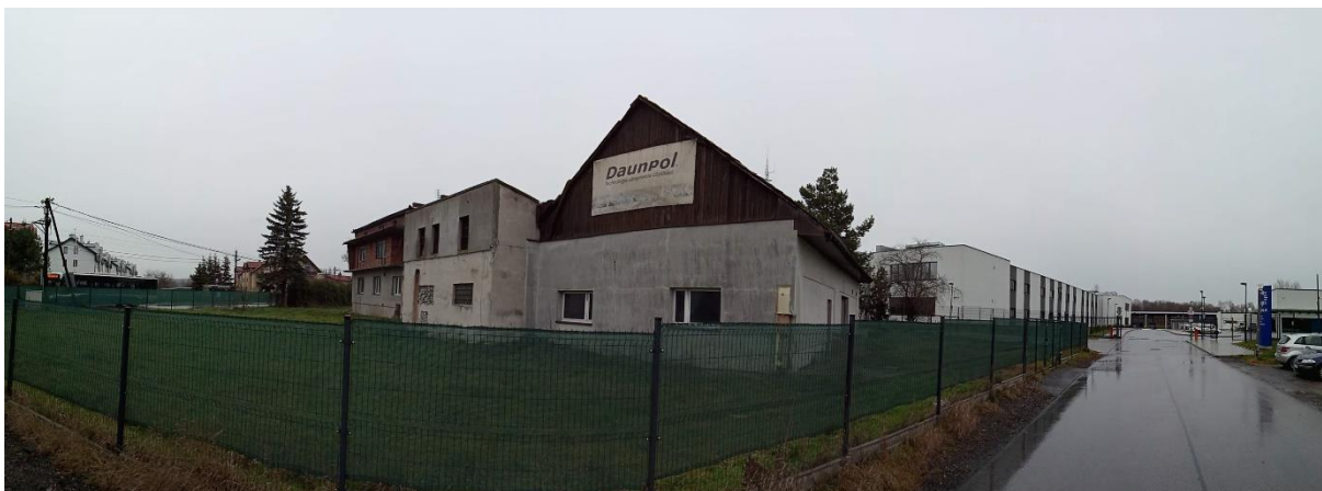
Fot. 4. Kompleks budynków policji w tle zabudowy „obszaru B” (Fot. A. Puchała).
