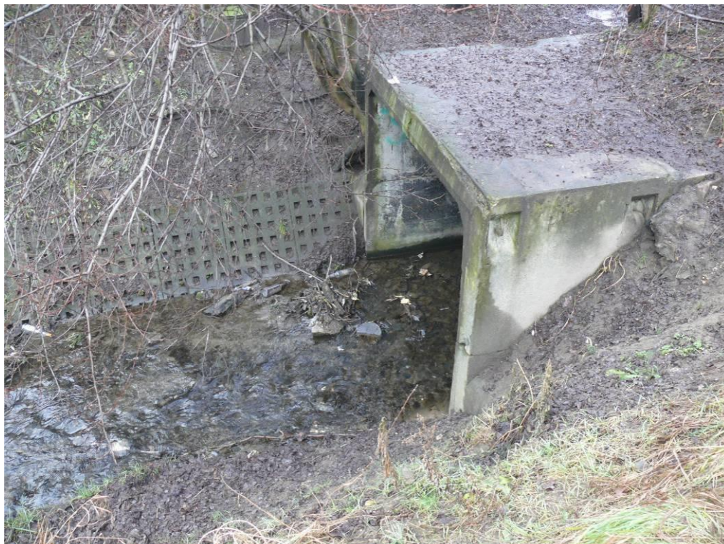
Fot.5. W odcinku, w którym ulica Pacholskiego przekracza Bibiczanekę, potok został przekryty na odcinku dłuższym niż to wynika z szerokości pasa drogowego. Utworzono w ten sposób jakby „przedłużony” przepust drogowy.
