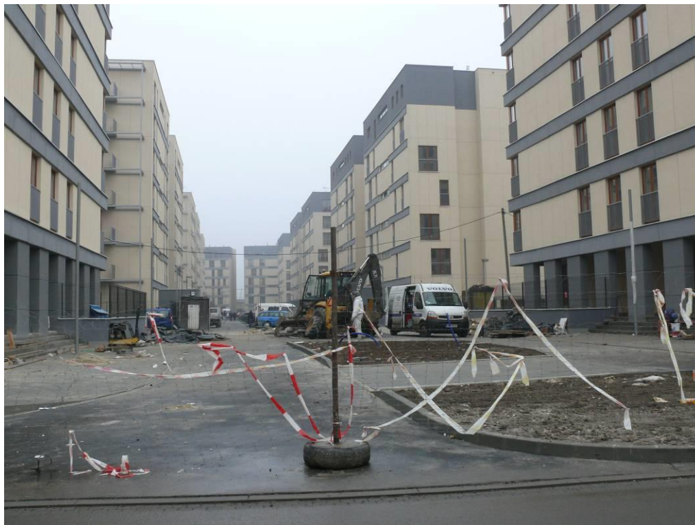
Fot.13. Wnętrze „komunikacyjne” osiedla pomiędzy ulicami Siewną i Bociana.
