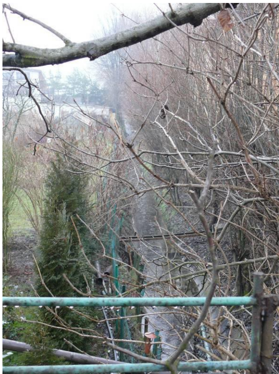
Fot.4. Wyprostowane i wyłożone płytami betonowymi koryto Bibiczanki powyżej ulicy Górnickiego.
