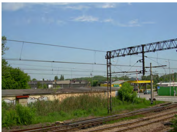
Fot.13 tory kolejowe widok w kierunku Krzemionek
