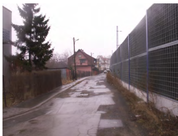
Fot.16 ekrany akustyczne oddzielające tory kolejowe
