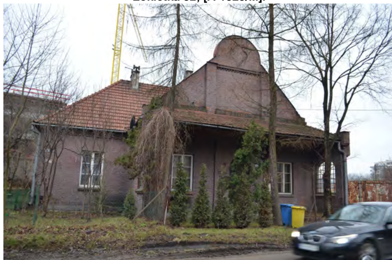
Fot 13. Budynek rogatki miejskiej – krowoderskiej „Pod Figurą”, ul. Łokietka 32; [A-1325/M].
