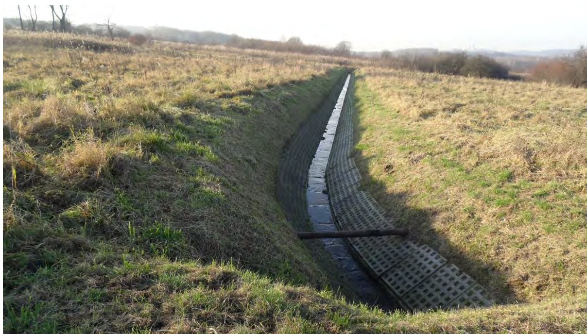
Fot. 3 Rów ( część obudowana), przecinający ul. Skotnicką (11.2016 r.)
