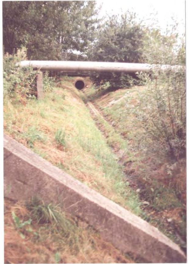
Fot.5.Pogłębione i uregulowane koryto Rowu Bieżanowskiego
