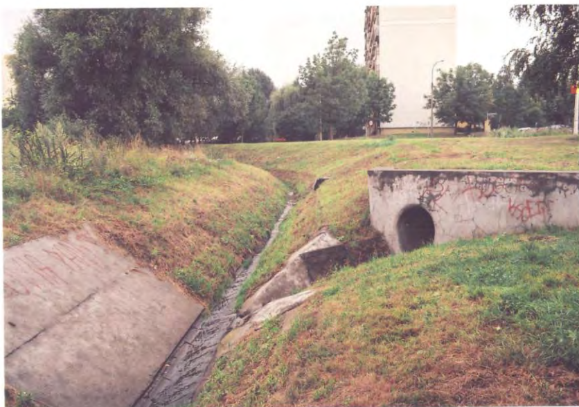
Fot.9.Rów Biezanowski jest odbiornikiem ścieków deszczowych
