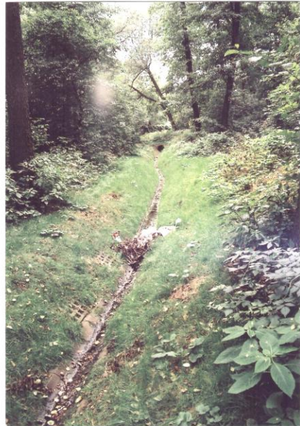
Fot.9. Obetonowane koryto źródłiskowego odcinka potoku Basta
