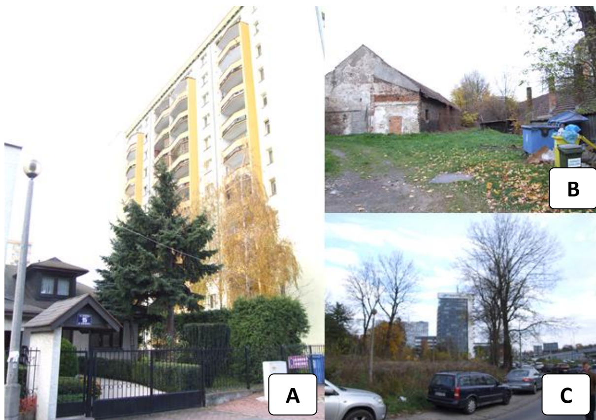
Fot. 11 Rzeczywiste sytuacje konfliktowe występujące w obszarze opracowania: A - sąsiedztwo zabudowy o znacznej różnicy wysokości, B - zabudowa w złym stanie technicznym przy ul. Dobrego Pasterza, C - zarastający teren dawnego osiedla interwencyjnego (w tle nowoczesna zabudowa usługowa) oraz licznie parkujące samochody przy ul. Promienistych.
