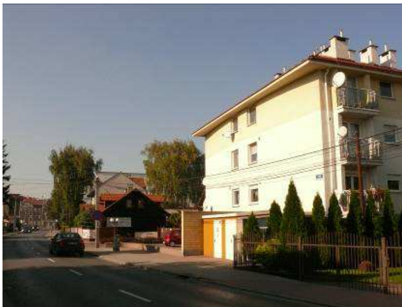
Fot.2.25. Nowy obiekt budowlany „zawieszony” nad drewnianym budynkiem dawnej zabudowy, dziś wykorzystywanym przez „studio urody” (fot. A. Sułkowski).
