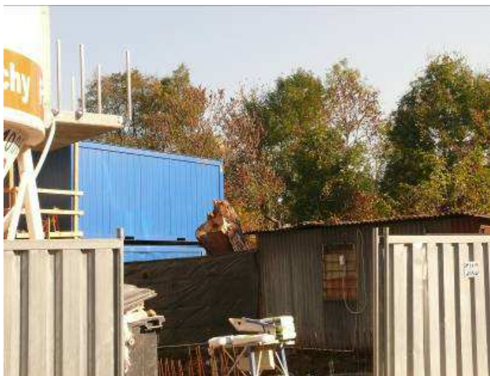
Fot.4.1. Wierzb po pracach „pielęgnacyjnych” mających udostępnić plac budowy maszynom budowlanym (ul. Na Barciach, fot. A. Sułkowski).
