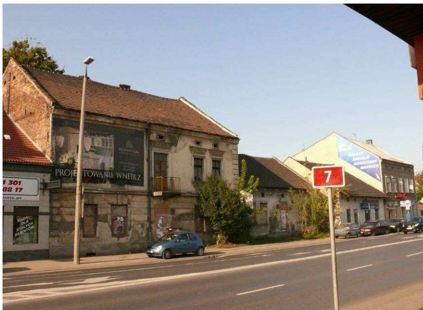
Fot.2.23. Popadające w ruinę obiekty mieszkalne przy ul. 29 Listopada (fot. A. Sułkowski).
