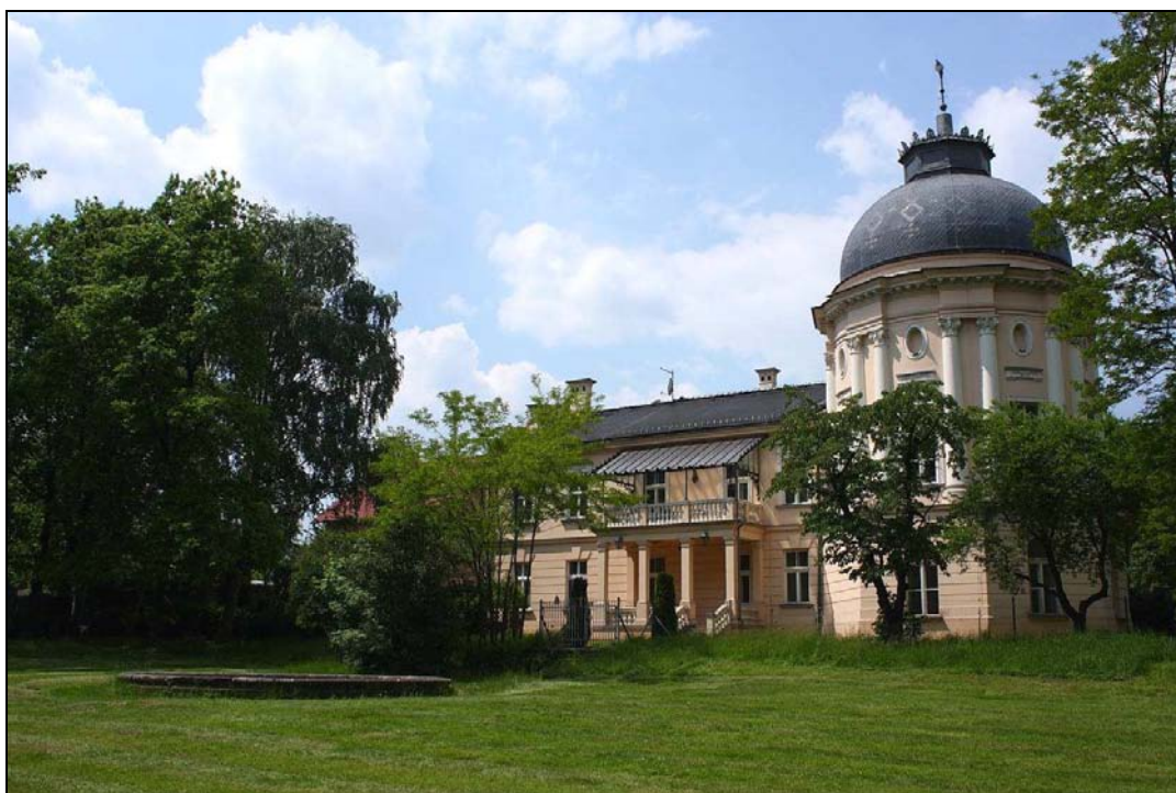
RYC. 23. PAŁAC JERZMANOWSKICH Widok w kierunku północno-zachodnim, 21.05.2016 r.
