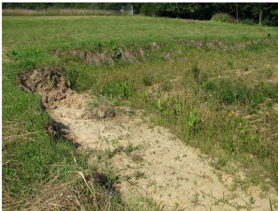
Fot.2.8. Osuwisko w obszarze rolniczym przy ul. Sztaudyngera – stoki niszy osuwiskowej (fot. J. Kowalczyk).
