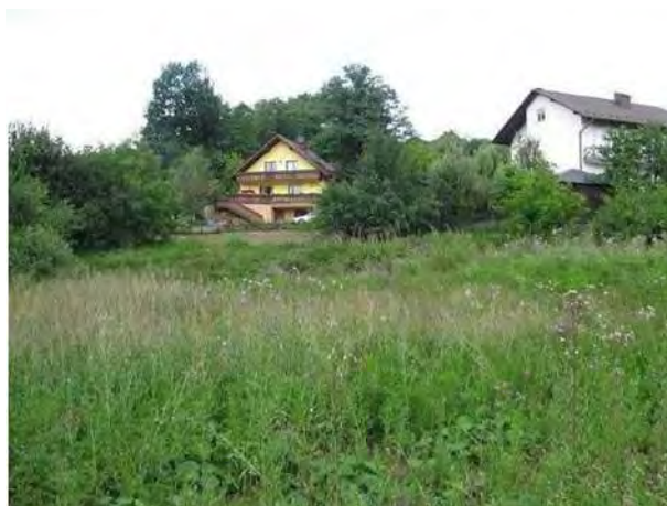
Fot.2.14. Obiekt mieszkalny na osuwisku wyłączonej z użytkowania ze względu na zagrożenie. Po prawej u góry – wyłączony obiekt, skarpa osuwiska - po prawej w środku, tablica ostrzegawcza – po prawej u dołu. Po lewej panorama terenu ponad wyłączonym obiektem.
