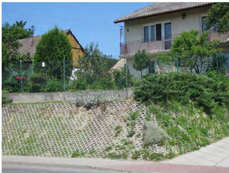
Fot.2.17. Umocnienie skarpy, poniżej znajduje się stok osuwiskowy, Soboniewice (fot. J. Kowalczyk).
