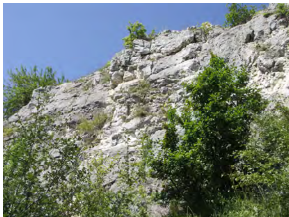
Fot. 1 Wychodnie skalne wapienia na południowy-zachód od obiektów TV Kraków
