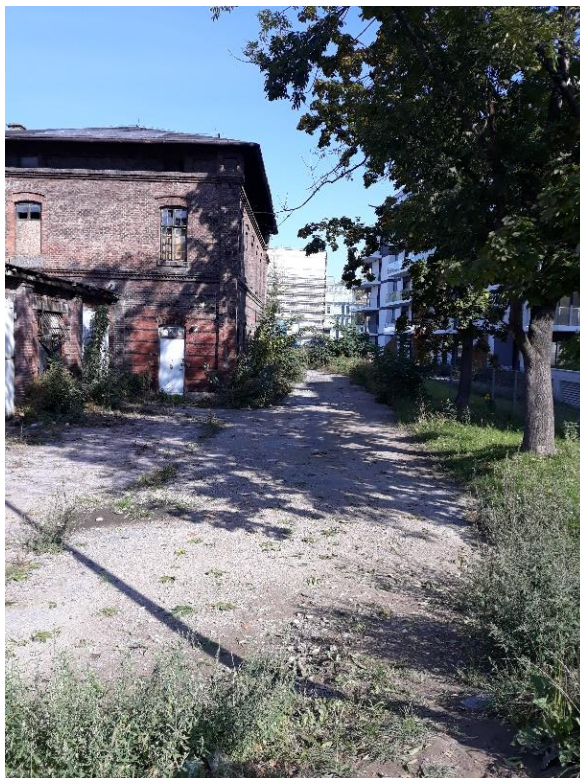
Fot. 3. Teren na przebiegu planowanej drogi dojazdowej KDD.5 – pomiędzy nową zabudowa wielorodzinną a zabytkowym obiektem dawnej Twierdzy Kraków – stan październik 2019r.
