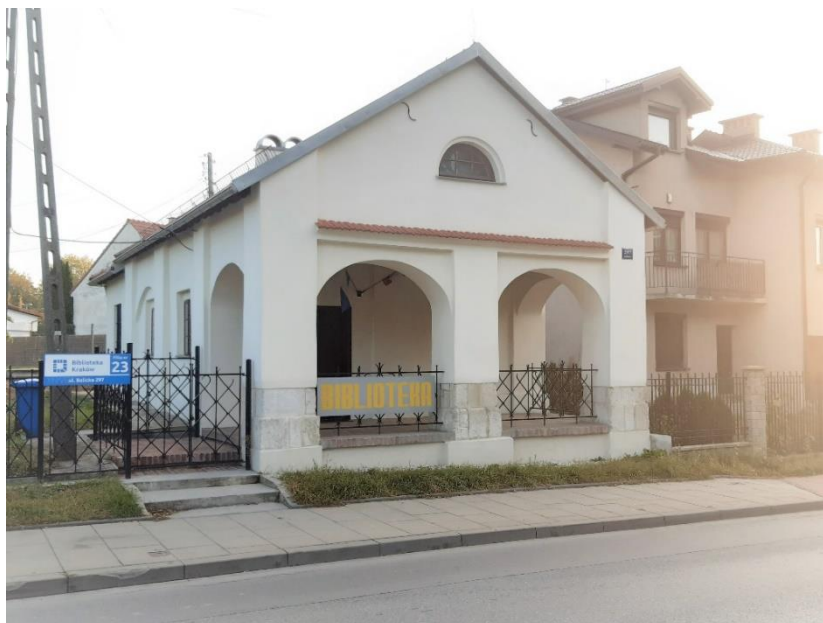
Fot. 16. Ul. Balicka 297 – dawna kuźnia w Mydlnikach (obecnie biblioteka), wrzesień 2019 r. [9].
