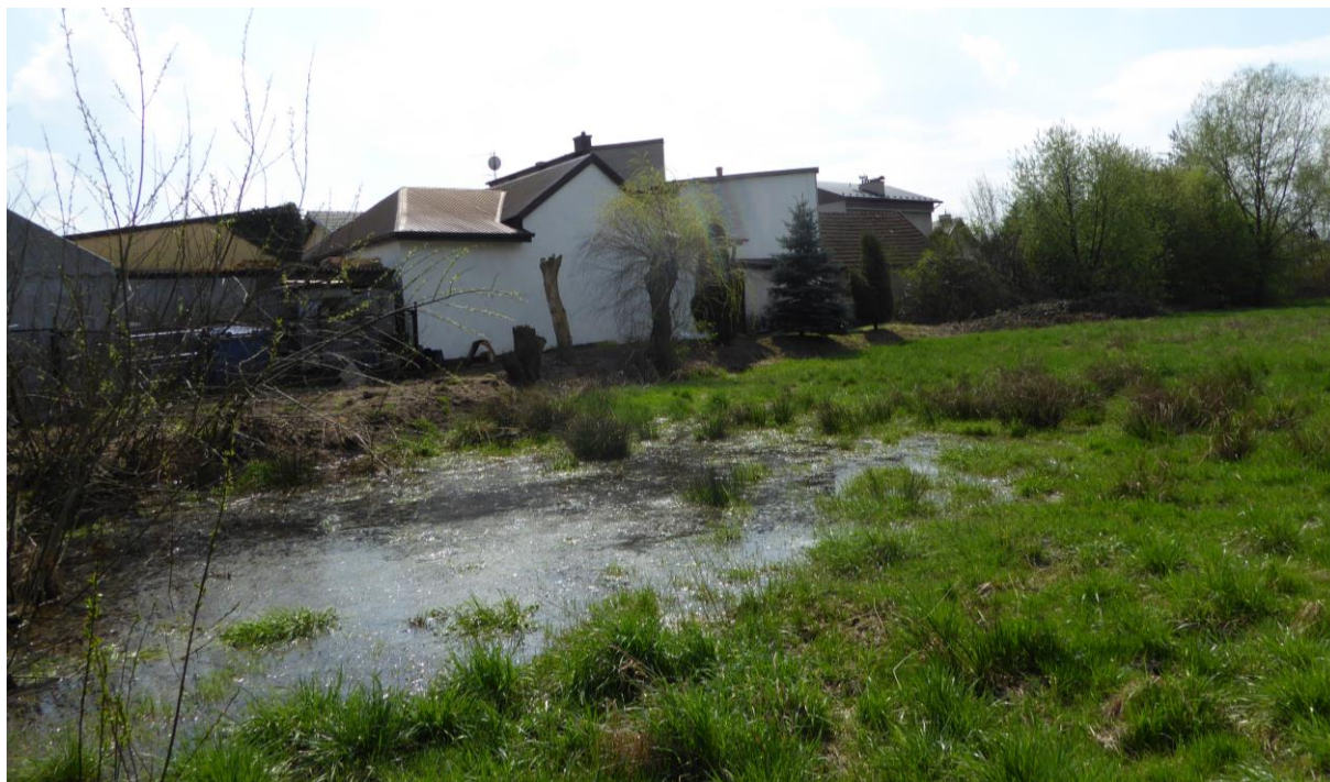
Fot. 3. Miejsce akumulacji wód we wschodniej części działki nr 256/4.
