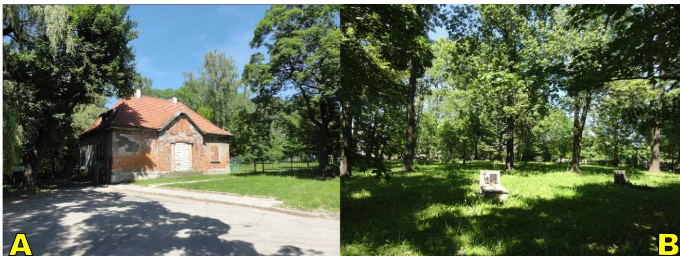
Fot. 4. Niewyremontowana kaplica cmentarna (A) oraz fragment starszej części cmentarza (B).
