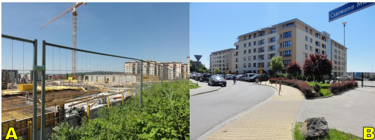
Fot. 2. Widok na trwającą budowę, w tle najwyższe budynki wielorodzinne (A), a także zabudowę typową dla północy obszaru z zielenią towarzyszącą (B).
