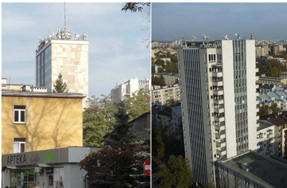
Fot. . Widoczne liczne urządzenia łączności na dachu Biprostalu oraz wieżowca przy skrzyżowaniu al. Kijowskiej oraz ul. Kazimierza Wielkiego (źródło: inwentaryzacja BPP UMK).
