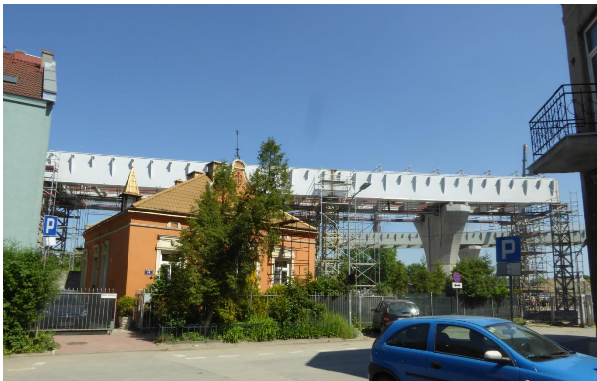
Fot. 2. Istniejąca zabudowa na tle estakady łącznicy kolejowej. Widok ze skrzyżowania ulic Tamowskiego i Hetmańskiej. Stan prac: maj 2016 r.
