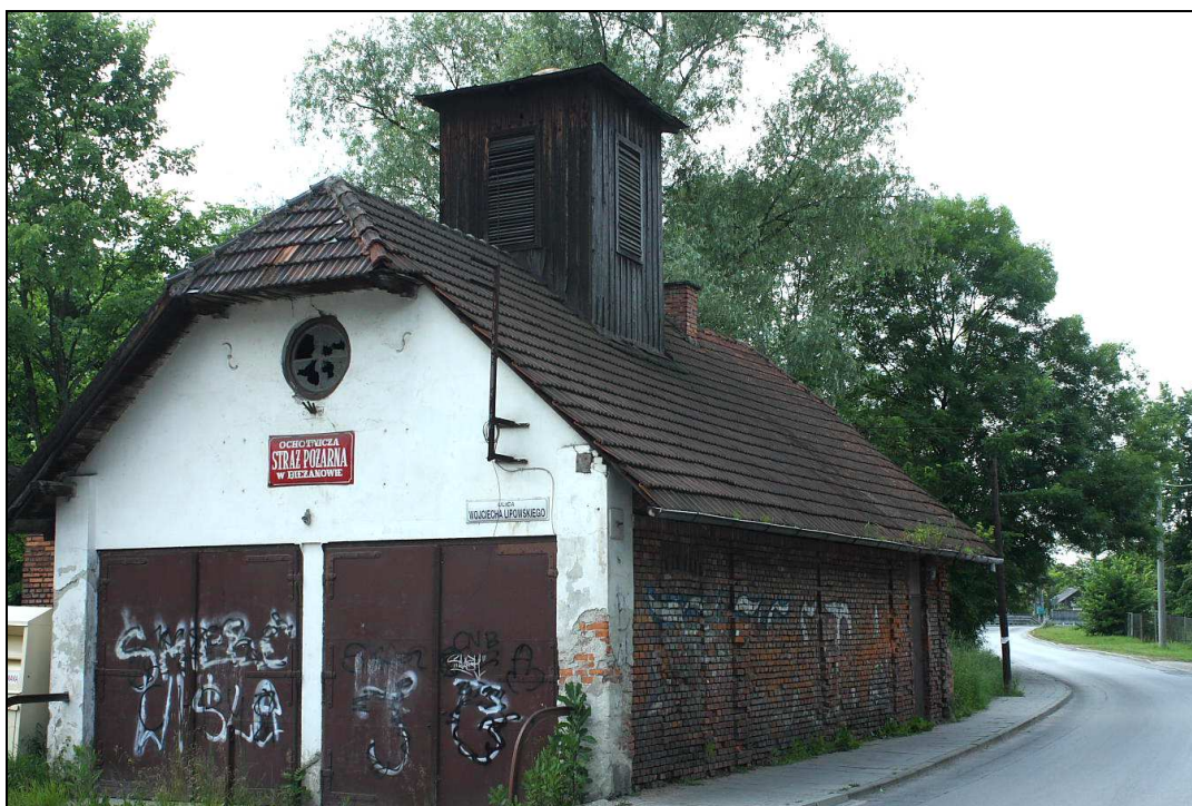
RYC. 24. BUDYNEK REMIZY Widok w kierunku zachodnim, 12.06.2016 r.
