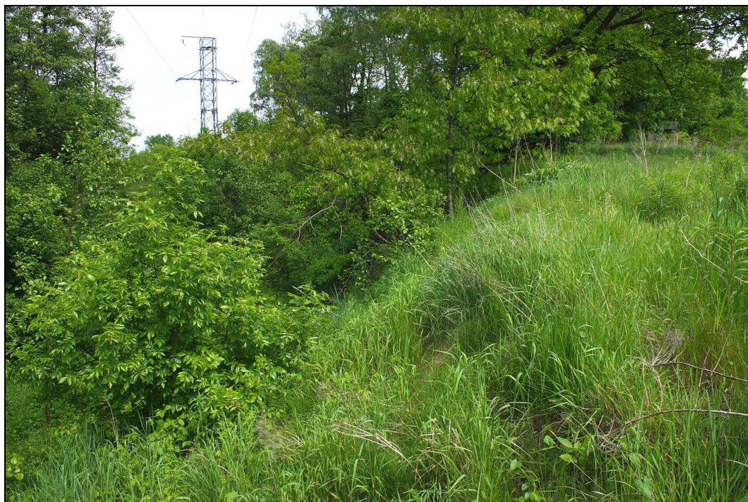
RYC. 7. OSUWISKO NA SZKLANEJ GÓRZE – SKARPA GŁÓWNA Widok w kierunku północno-wschodnim, 21.05.2016 r.
