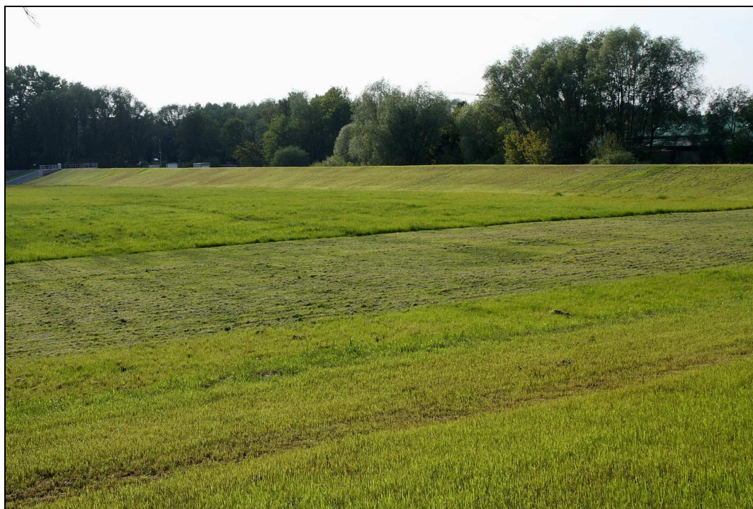
RYC. 14. SUCHY ZBIORNIK "BIEŻANÓW" – CZASZA I ZAPORA CZOŁOWA Widok w kierunku północno-zachodnim, 21.05.2016 r.
