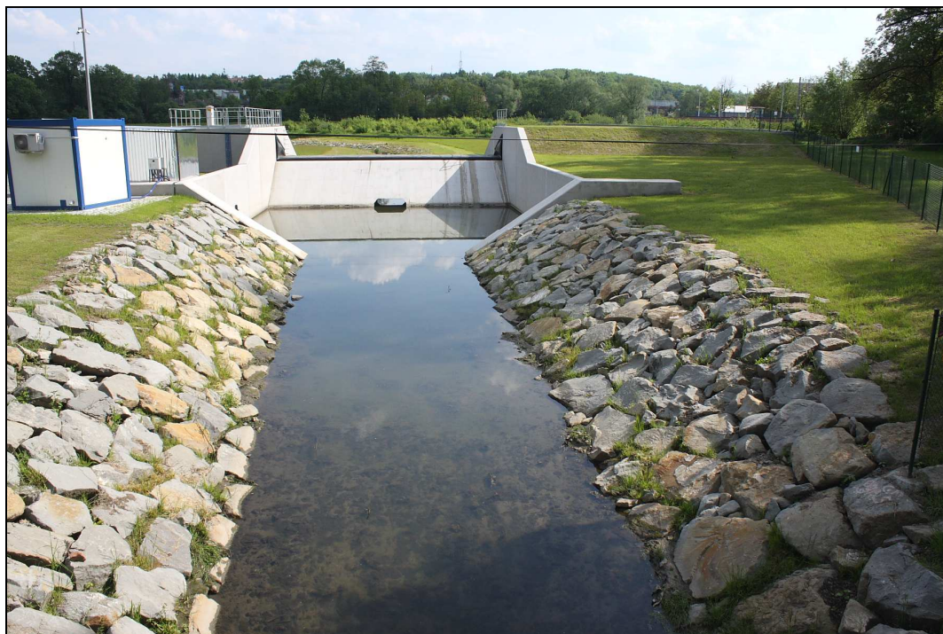
RYC. 13. SUCHY ZBIORNIK "BIEŻANÓW" – URZĄDZENIA UPUSTOWE Widok w kierunku południowym, 21.05.2016 r.
