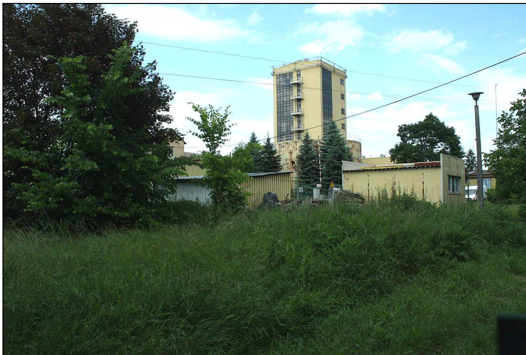
RYC. 23. DROŻDŻOWNIA W BIEŻANOWIE Widok w kierunku północnym, 12.06.2016 r.
