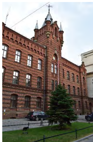
Fot. 30 Budynek Straży Pożarnej – wpisany do rejestru pod numerem A – 572.
