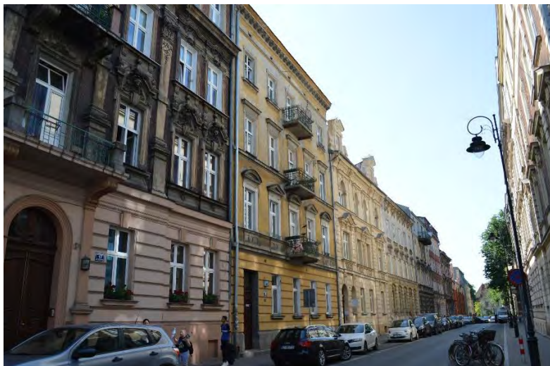
Fot. 19 Fasady kamienic w ciągu ulicy Jagiellońskiej.
