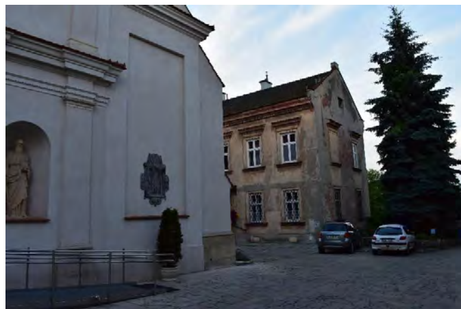
Fot. 31 Zespół budynków: Kościół i Plebania.
