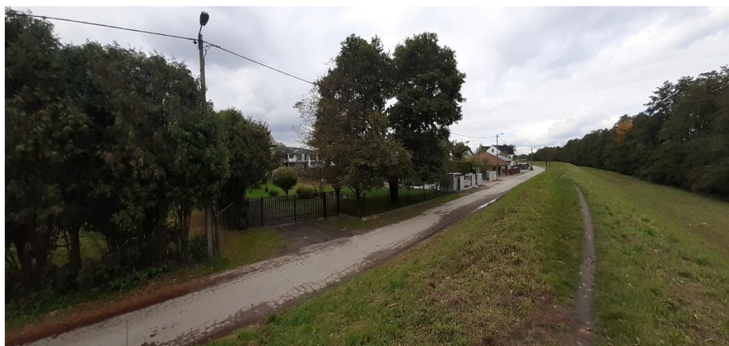
Fot. 21 Wgląd z obwałowań rzeki Rudawy na zabudowania zlokalizowane przy ul. Korbutowej.
