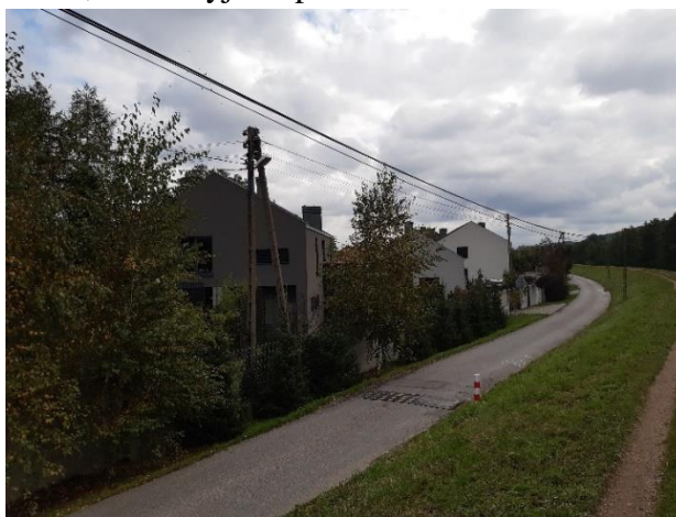
Fot. 10 Zabudowa zlokalizowana przy ul. Zarudawie.
