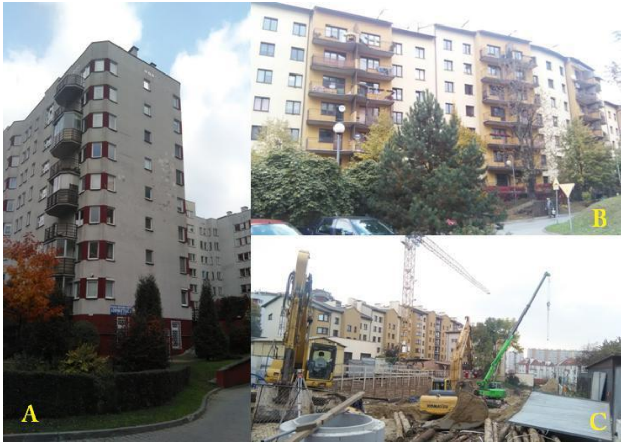
Fot. 6. Zabudowa wielorodzinna w obszarze opracowania (A i B) oraz trwająca budowa obiektu wielorodzinnego przy ul. Ułanów (C).
