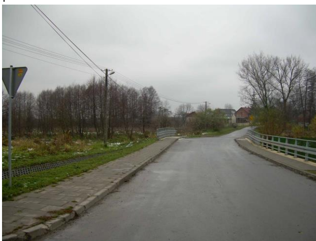
Fot.9. Most na potoku Kościelnickim – ul. Ostafina
