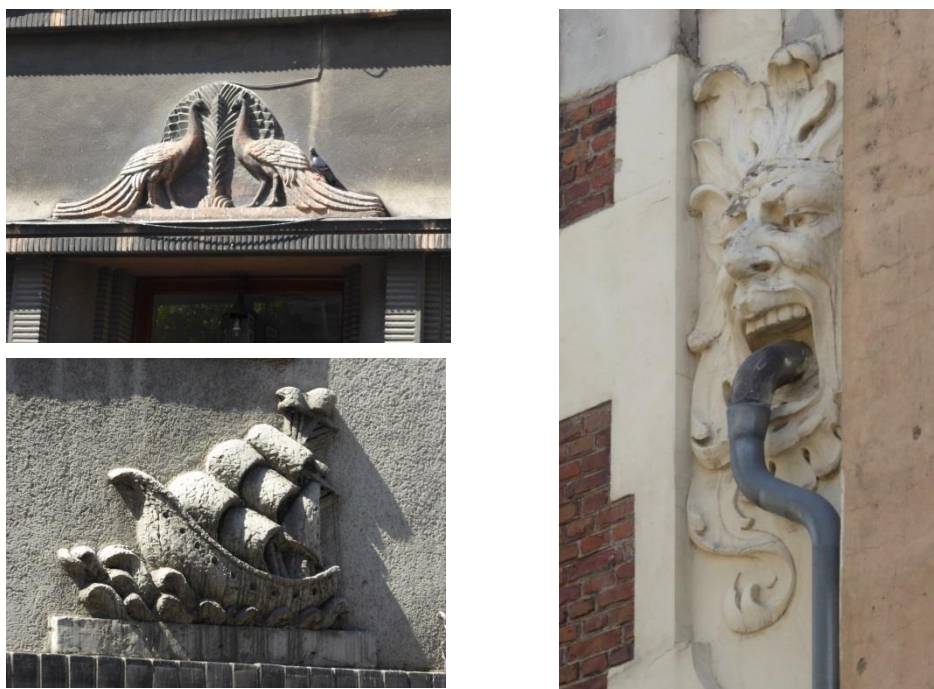
Fot. 20. Detale na elewacjach budynków
