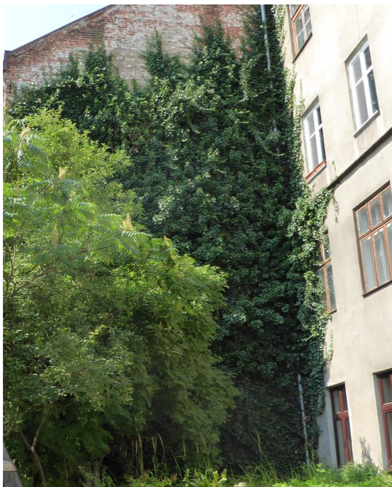
Fot. 12. Zielona „ściana” bluszczu pospolitego na budynku w podwórku przy ulicy Pędzichów.
