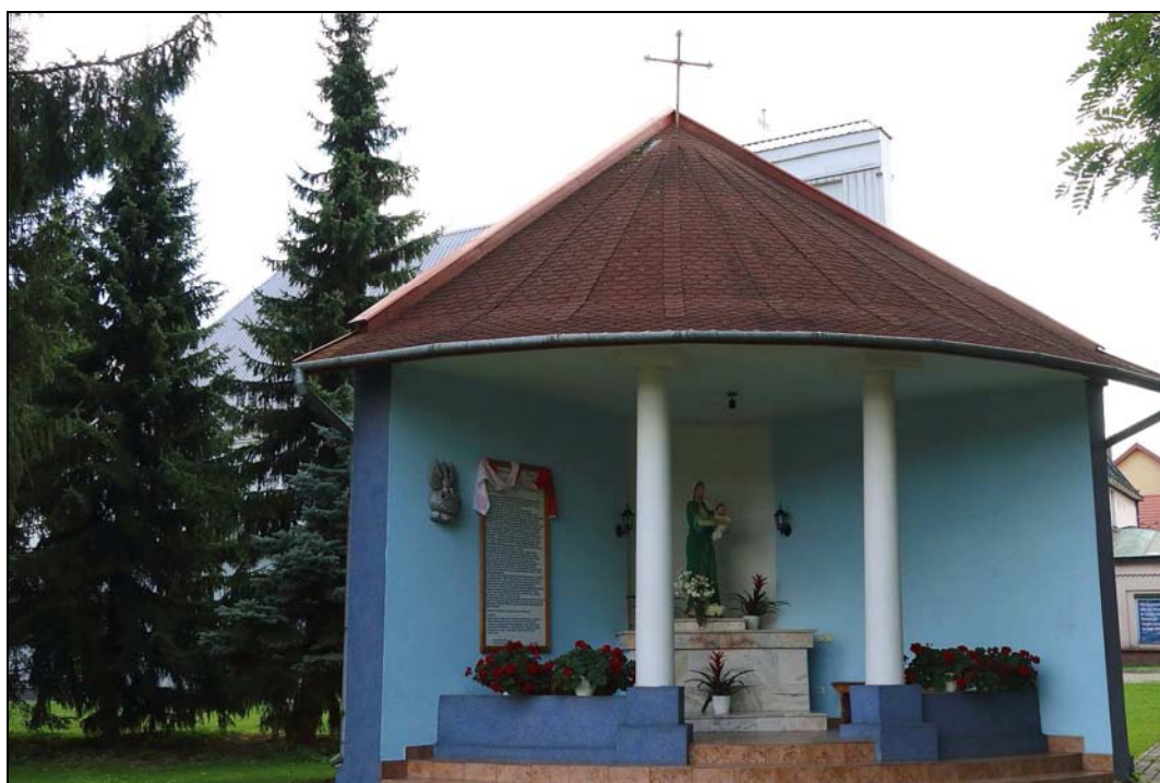
RYC. 24. KAPLICA PRZY KOŚCIELE PARAFIALNYM W OLSZANICY Widok w kierunku południowym, 14.09.2019 r.
