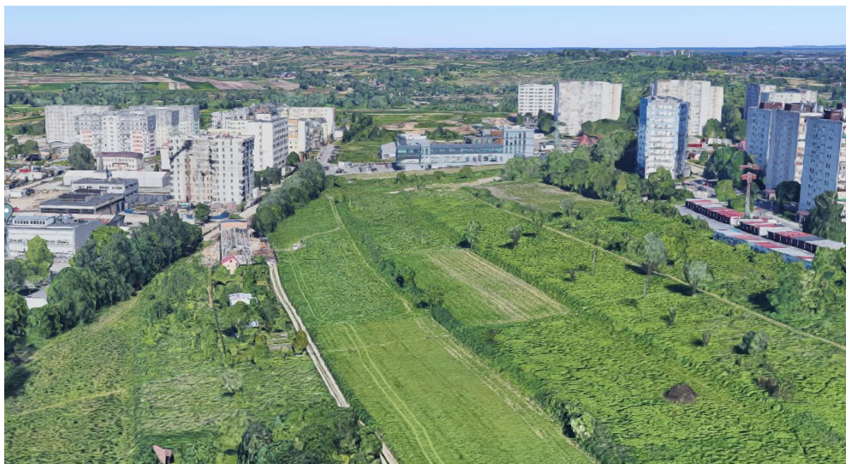
Ryc. 19. Widok na tereny projektu planu przeznaczone głównie pod zabudowę wielorodzinną (wizualizacja: Mapy Google 3D https://www.google.pl/maps - dostęp: 05.03.2020r.) - tereny przewidywanych bardzo istotnych zmian w krajobrazie.
