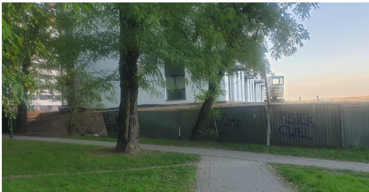
Fot. 3 Intensywna zabudowa deweloperska na północ od osiedla Piastów (poza granicami projektu planu) widoczne całkowite przekształcenia mas ziemnych (nadsypanie w stosunku do przyległych pól i parku fortecznego o prawie 2m) (październik, 2019r.)
