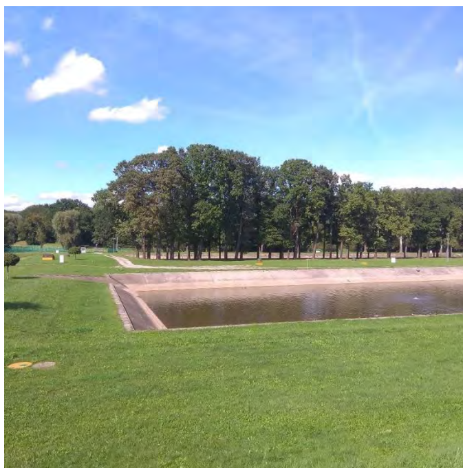
Fot. 12. Drzewa rosące wokół basenu na terenie strefy ochronnej ujęcia wody.
