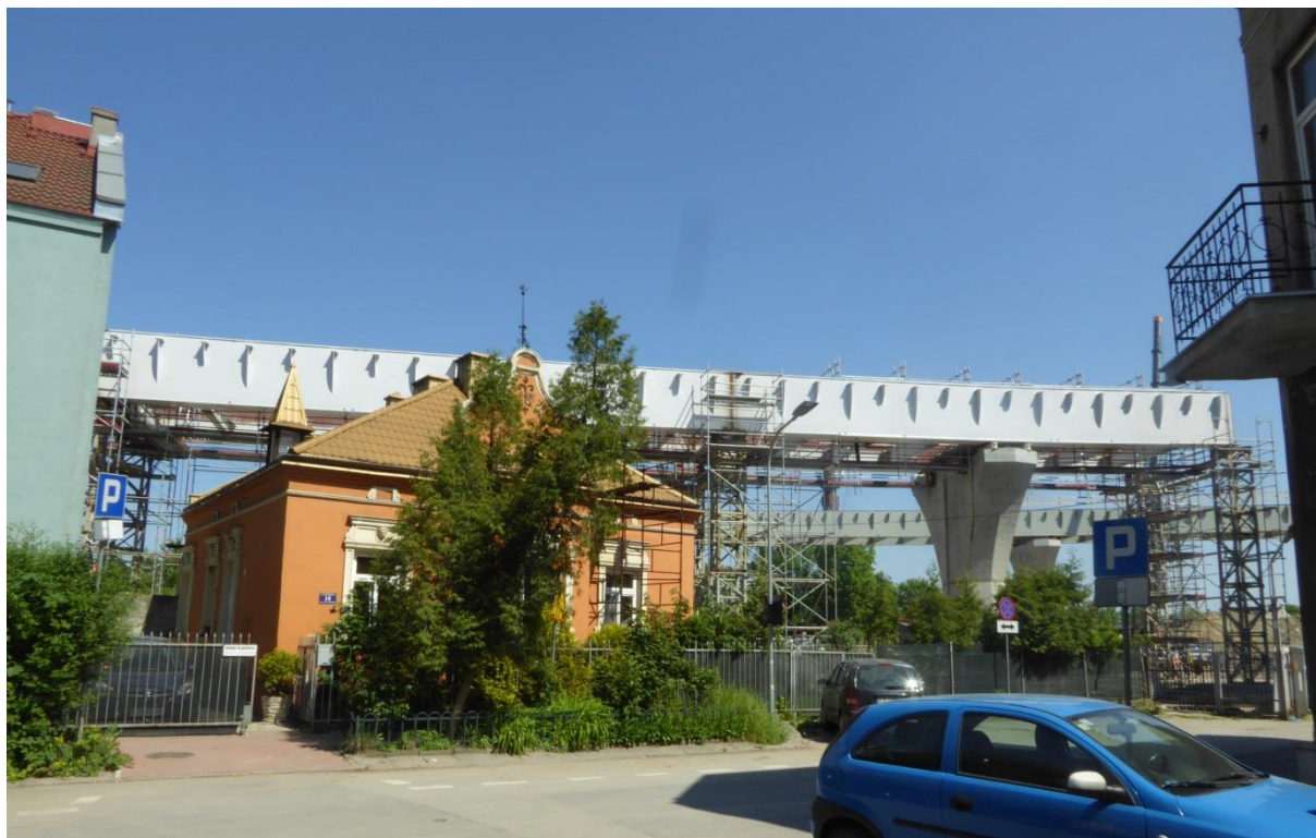
Fot. 2. Istniejąca zabudowa na tle estakady łącznicy kolejowej. Widok ze skrzyżowania ulic Tarnowskiego i Hetmańskiej. Stan prac: maj 2016 r.
