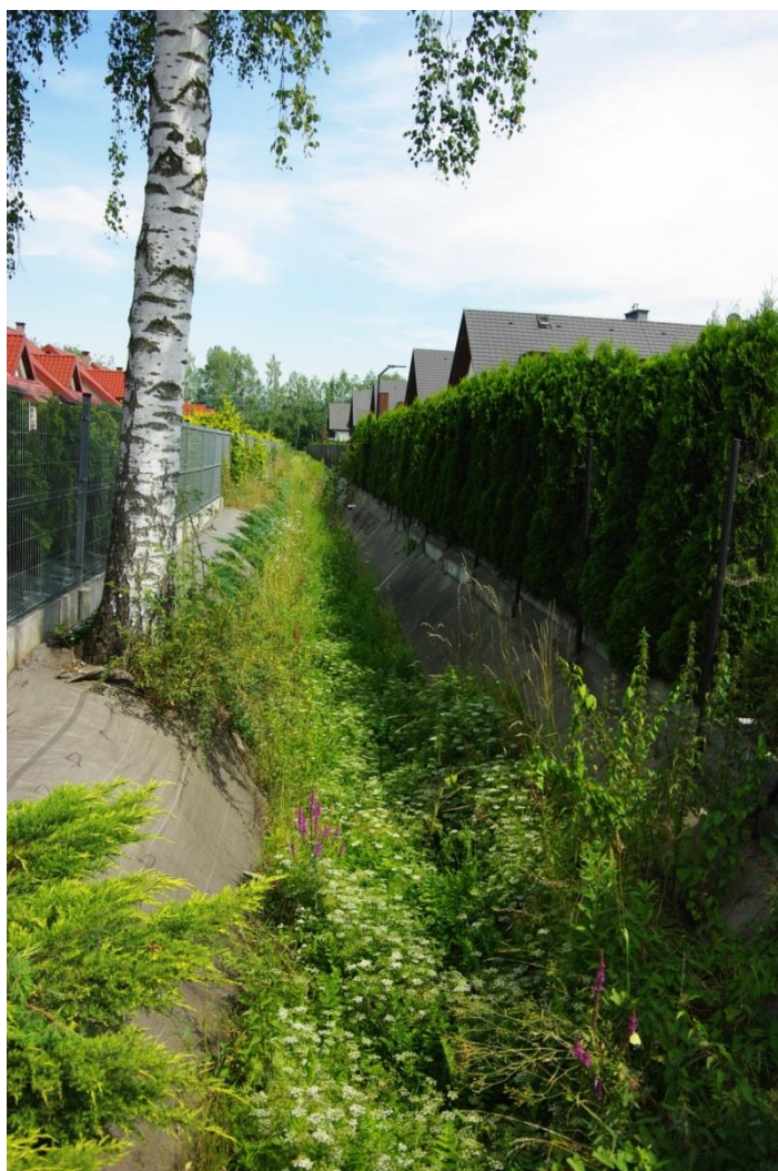
Fot. 13. Rów wyłożony matą ogrodniczą między zwartymi zespołami zabudowy w południowej części obszaru opracowania.
