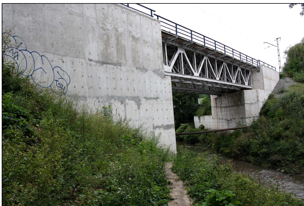
FOT. 6. RZEKA BIAŁUCHA (PRĄDNIK) – MOST W CIĄGU LINII KOLEJOWEJ NR 100 Widok w kierunku północnym, 02.09.2017 r.
