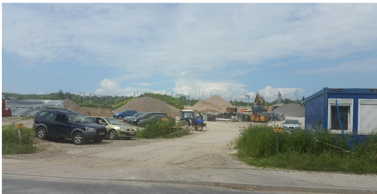
Fot. 6 Teren MW/U.5 i U.2 - niezabudowane działki położone pomiędzy linią kolejową a ul. Balicką, które w ostatnim czasie zostały całkowicie pozbawione szaty roślinnej (fot. Pracownia Urbanistyczna BP, czerwiec 2019 r.)
