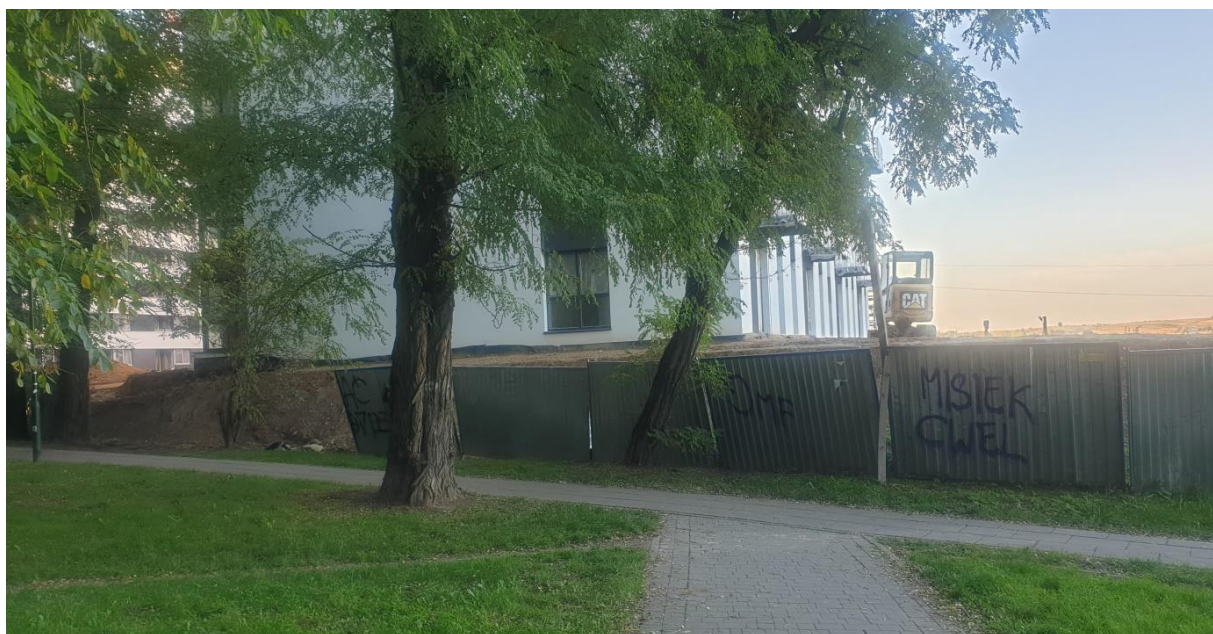
Fot. 3 Intensywna zabudowa deweloperska na północ od osiedla Piastów (poza granicami projektu planu) widoczne całkowite przekształcenia mas ziemnych (nadsypanie w stosunku do przyległych pól i parku fortecznego o prawie 2m) (październik, 2019r.)
