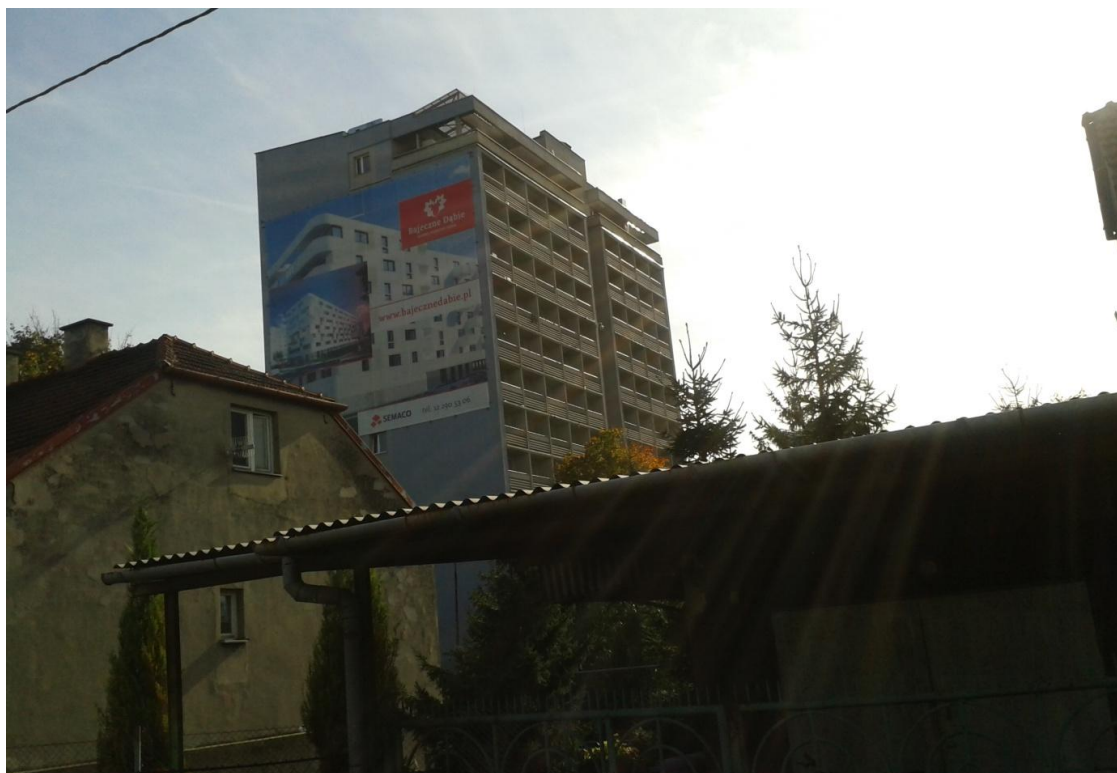
Fot. 8 Widok zabudowy od strony al. Jana Pawła II.
