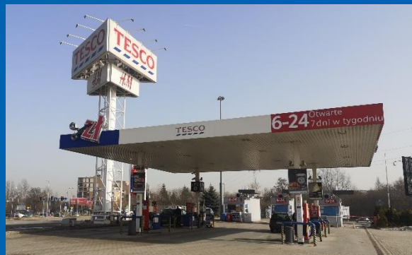
Fot. 2 Stacja paliw przy ul. Kobierzyńskiej.
