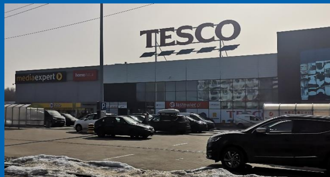
Fot. 1 Budynek CH Tesco.
