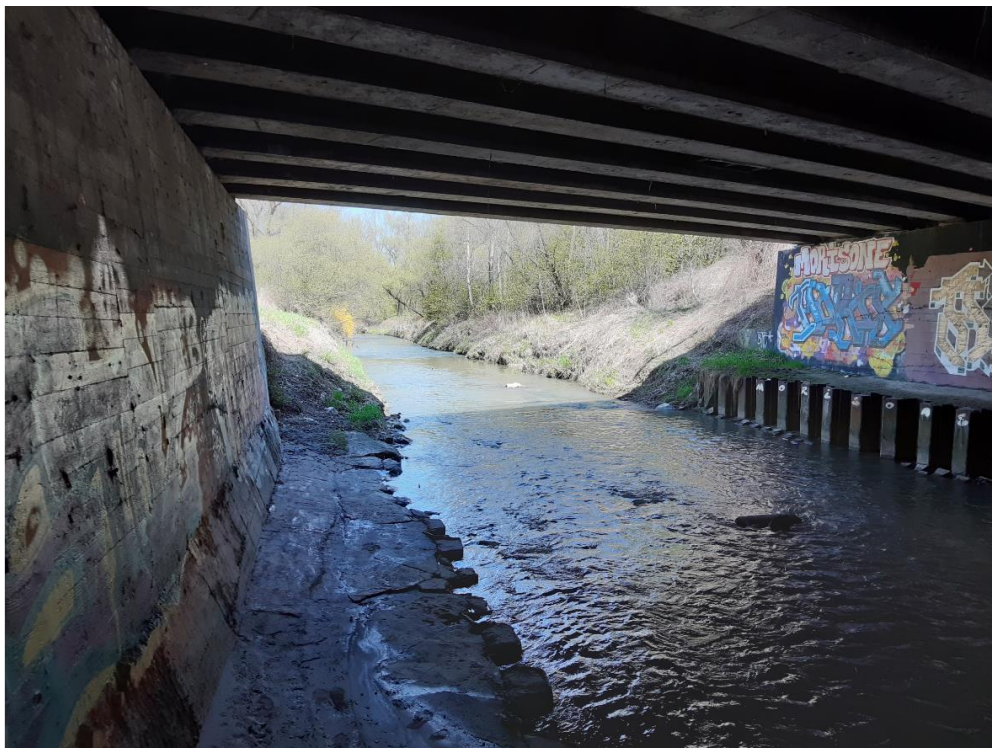
Fot. 1. Rzeka Wilga – przepust pod ul. Brożka (kwiecień, 2021).
