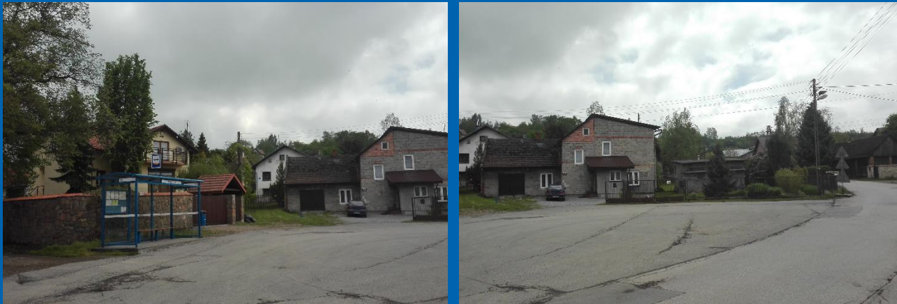
Wygląd jezdni ul. Rzepichy. Stan na dzień inwentaryzacji.
