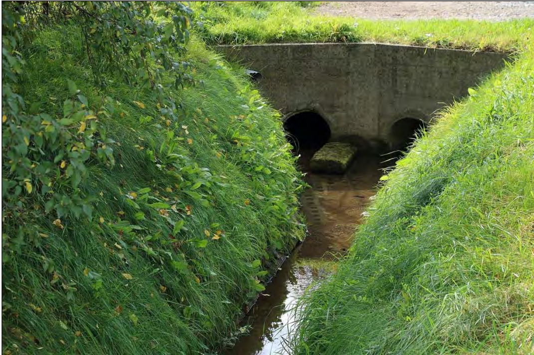
Fot. 2 Rów przy ul. Chełmskiej, blisko ronda. Widok w kierunku południowym, w górę biegu, 03.10.2019 r.
