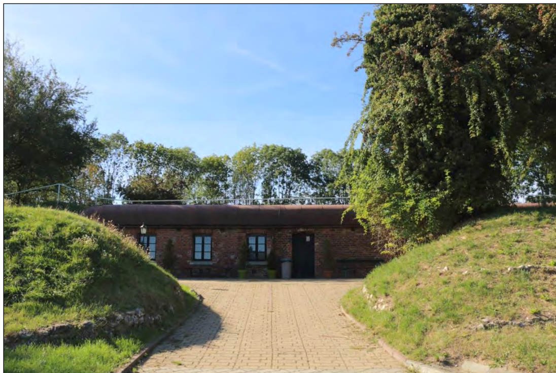
Fot. 22 Fort Olszanica. Widok w kierunku zachodnim, 15.09.2019 r.
