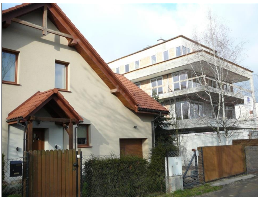
Fot. 10. Budynek wielorodzinny powstający w bezpośrednim sąsiedztwie domu jednorodzinnego.
