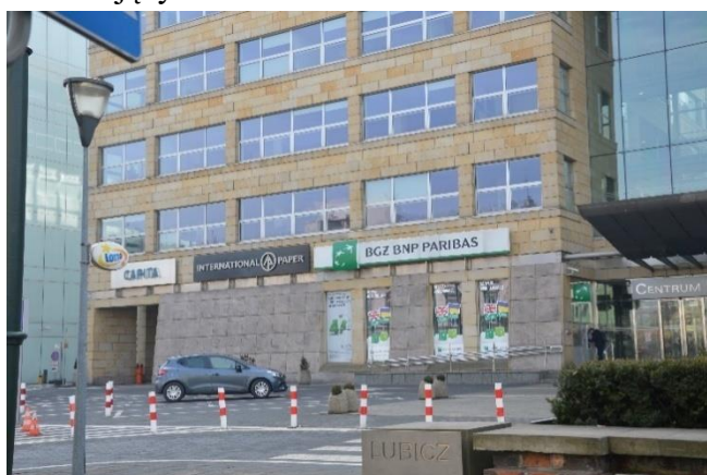
Fot.14 Budynek biurowy przy ul. Lubicz.
