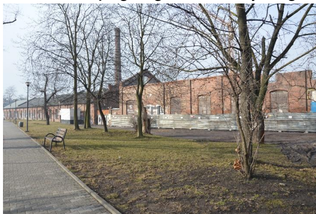
Fot. 17 Widok na wschodnią, zewnętrzną ścianę JARK zabytkowego zespołu zabudowań fabrycznych.
