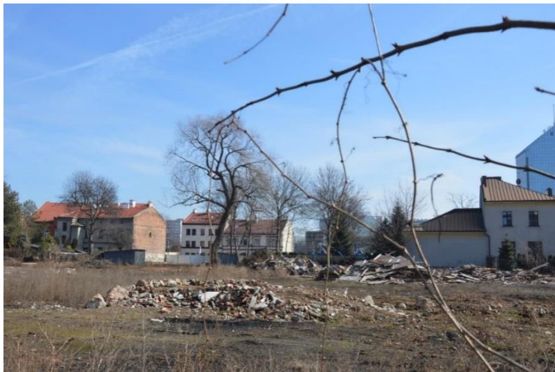
Fot. 9 Zieleń nieurzadzona na terenach niezainwestowanych, powstałych po wyburzeniach budynków przy ul. Grzegórzeckiej.
