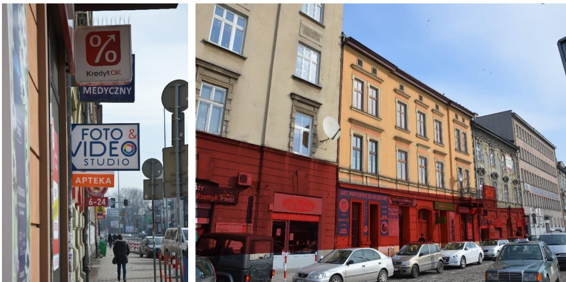
Fot. 29 i 30 Oszpecone fasady przy ul. Grzegórzeckiej.
