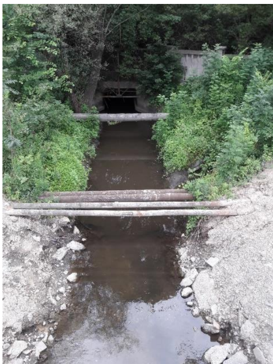
Fot. 1 Kanał Suchy Jar (rejon przepustu pod ul. Igołomską)
