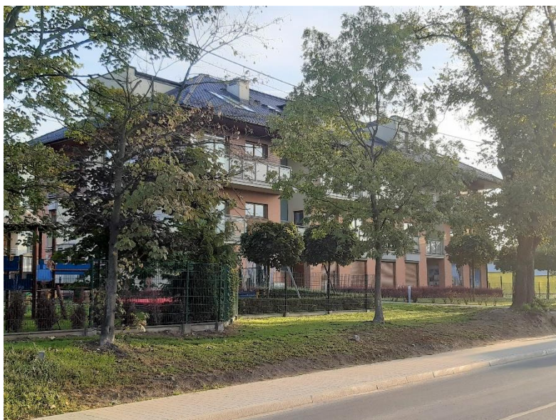
Fot. 19 Osiedle domów wielorodzinnych przy ul. Balickiej, wrzesień 2019 r.
