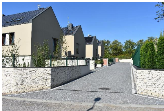
Fot. 21. Osiedle przy ul. Na Wirach.
