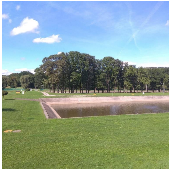
Fot. 11. Drzewa rosnące wokół basenu na terenie strefy ochronnej ujęcia wody.
