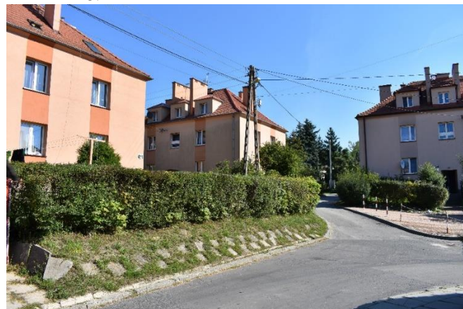
Fot.26. Budynki mieszkalne ul. Astronautów.
